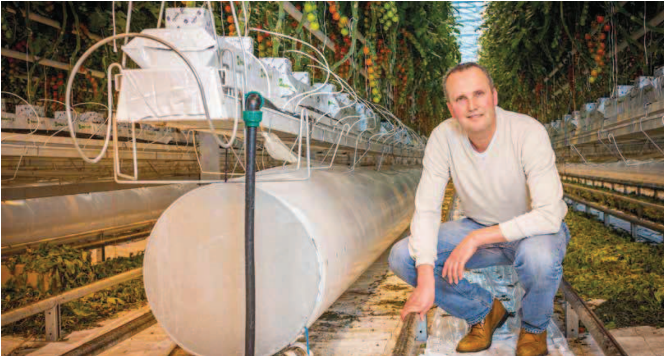
Volgens Jeroen Steenbrink vervult het cv-element in de installatie een belangrijke rol, omdat dit voorkomt dat er te koude lucht onderin de kas wordt gebracht.
