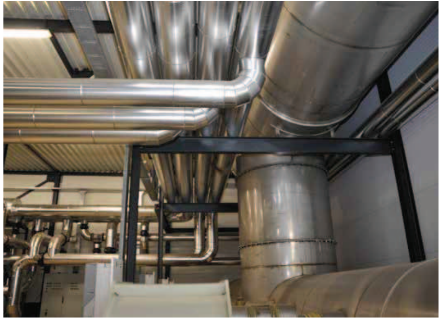
De CO 2 -sets zijn al meerdere malen aangepast. Zo zijn enkele ventilatoren van 22 kW vervangen voor 11 kW.
