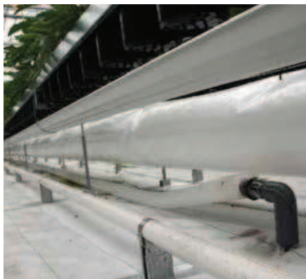
De luchtslangen onder de teeltgoten zorgen ervoor dat het klimaat onder de planten droger en boven de planten egalier is.
