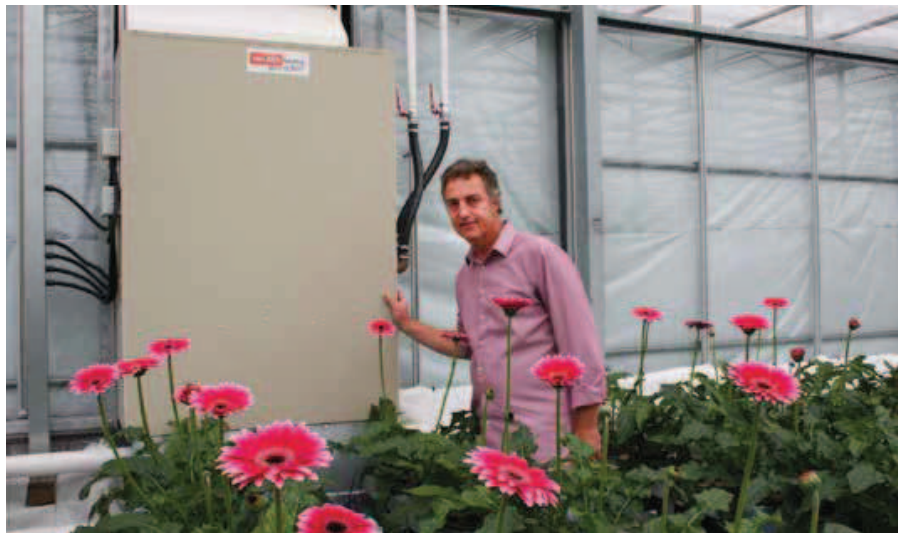
Joek van der Zeeuw: “Door buitenlucht met het systeem in de kas te doseren, krijg je een klein beetje overdruk. Daardoor is de temperatuurverdeling in de hele kas gelijkmatiger.”
